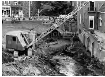
Herstel brug Bergpoort
